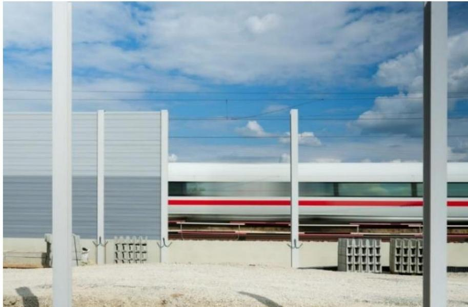
Figure 23 : Installation d'un mur antibruit. © Deutsche Bahn AG Oliver Lang
