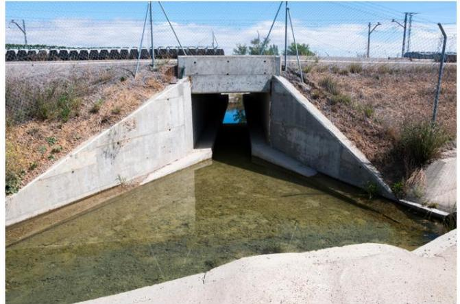
Figure 11 : Exemples de caniveaux passant sous les rails et permettant le passage de l'eau et des animaux
